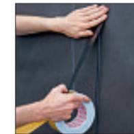
**Klebeband f. luft- und winddichte Verklebungen**
